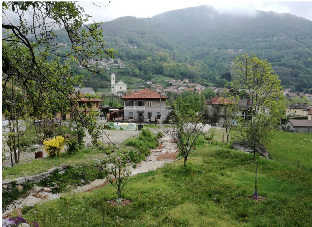
Figura 16 Visione completa tratto a monte del manufatto di imbocco del nuovo by-pass
