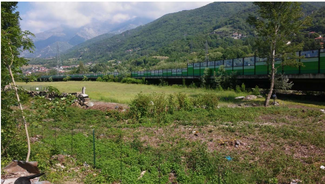
Figura 2 Area a valle della scarpata e SP 166 dir
