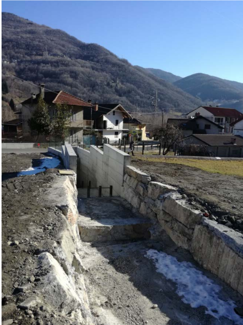
Figura 19 Vista da monte verso valle dell'inizio del manufatto di imbocco del nuovo by-pass
