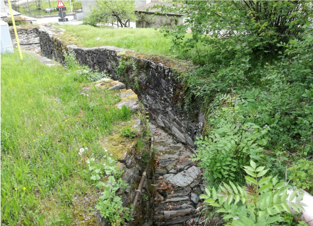
Figura 13 Vista da monte verso valle in corrispondenza del 2° attraversamento
