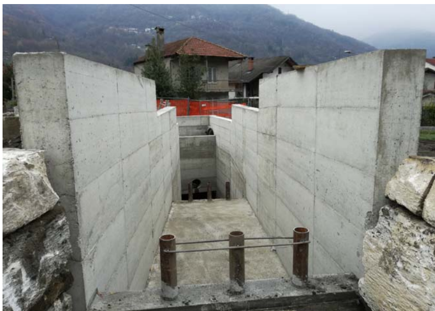
Figura 20 Imbocco manufatto scatolare by-pass dell'attraversamento della S.P.166
