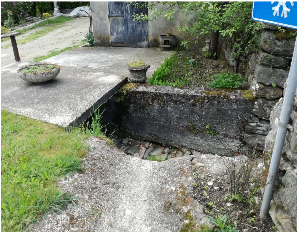
Figura 14 Imbocco attraversamenti di valle
