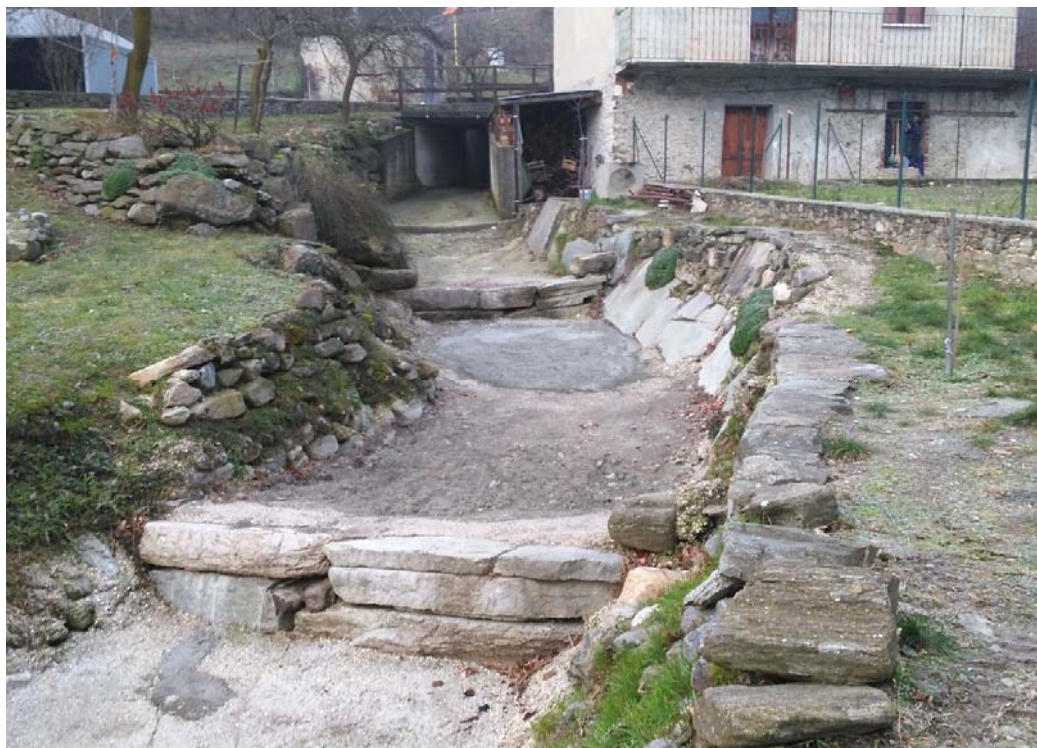
Figura 17 Vista da valle verso monte dello sbocco degli attraversamenti di valle
